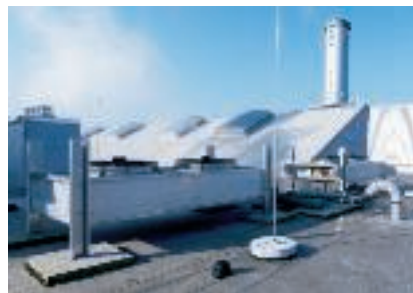
Изолированная молниезащита для кровельных надстроек
